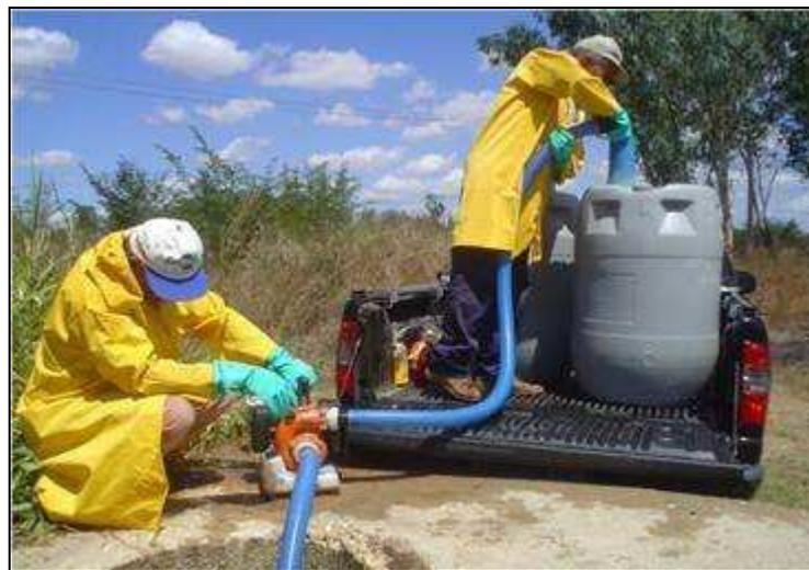
**Figura 29.** Detalhe do uso de EPI's no momento da sucção do efluente ao reservatório de PVC.
