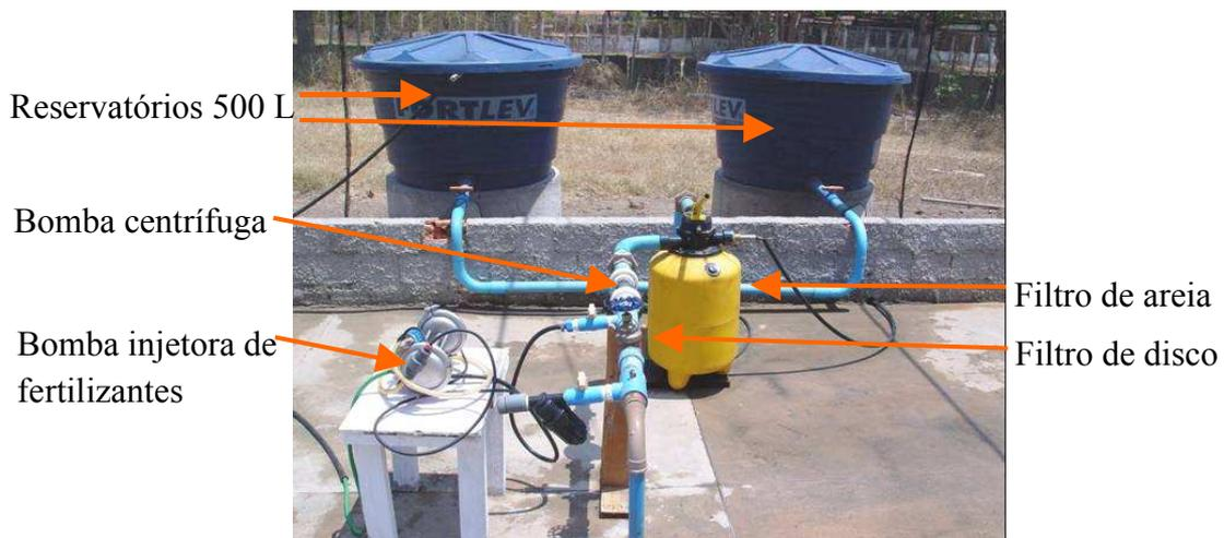
**Figura 19.** Detalhes do sistema de irrigação utilizado durante o experimento.
