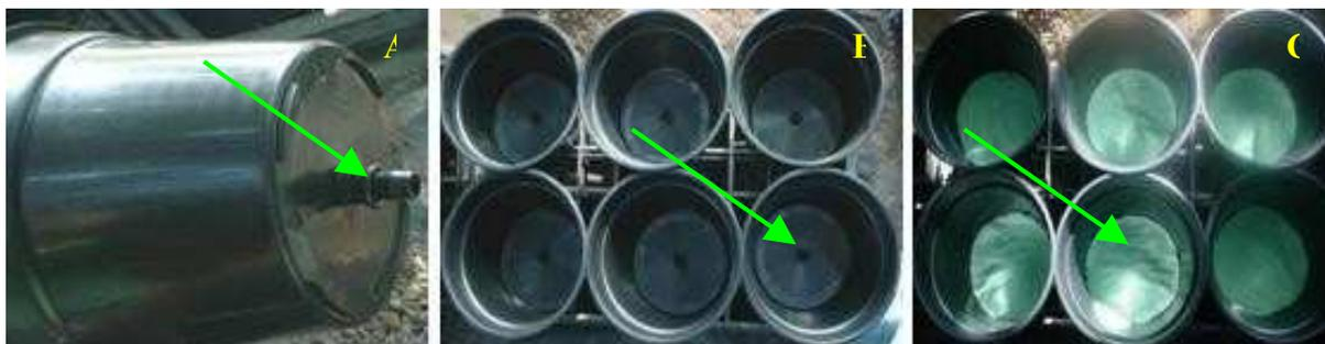
**Figura 11.** Detalhes do sistema de drenagem da água: conector (A), vasos com conectores (B) e manta geotêxtil no fundo (C).
