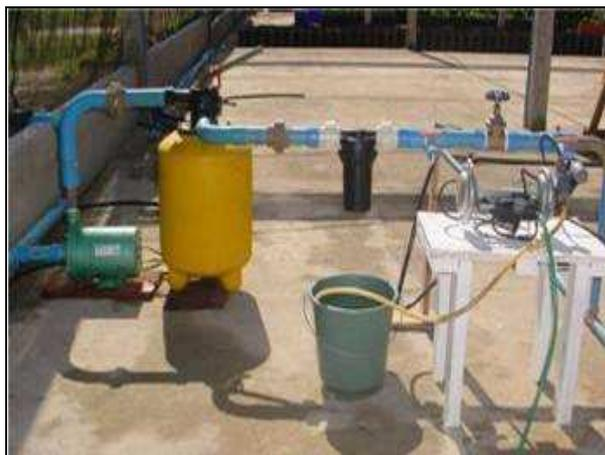
**Figura 25.** Aplicação de fertilizantes via bomba injetora.
