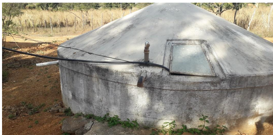
Figura 3: Bomba elétrica retirando água da cisterna.
