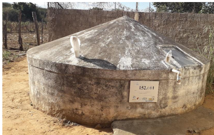
Figura 2: Cisterna de placa.
