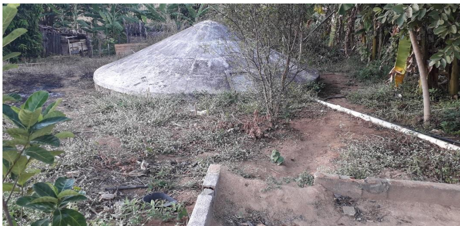
Figura 6: Cisterna de calçadão.
