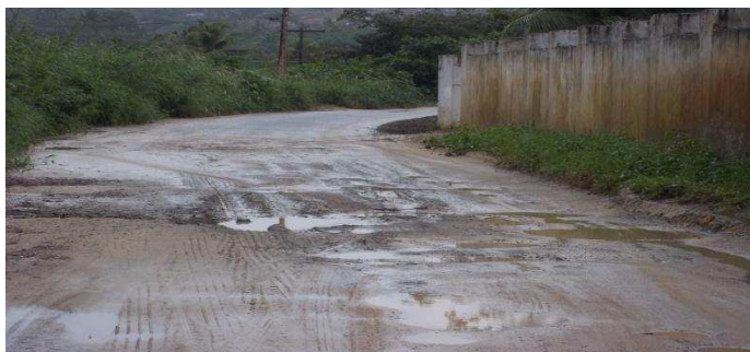
Figura VI: outro trecho da via de acesso até a empresa. Foto: William Soares.
