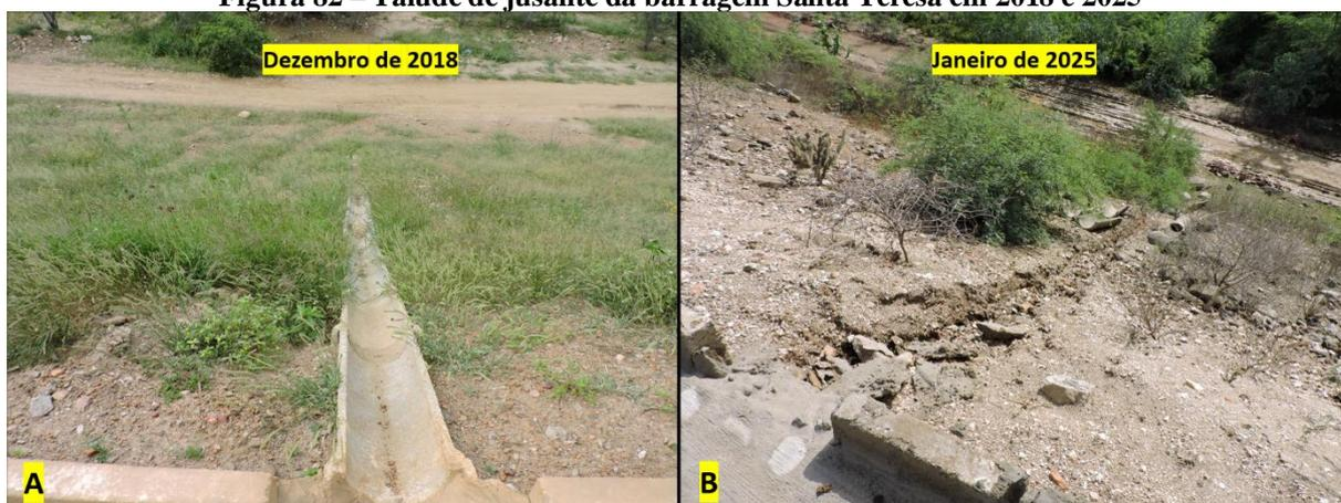
**Fonte:** Autoria própria (2018/25). Legenda: A) Foto do talude de jusante da barragem Santa Teresa com as calhas de drenagem no ano de 2018. B) Foto do talude de jusante da barragem Santa Teresa sem as calhas de drenagem, com erosão pelas águas pluviais e com presença de arbusto de algaroba em 2025.
