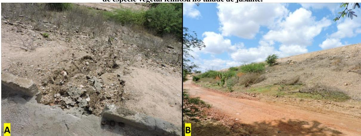
**Fonte:** Autoria própria (2024). **Legenda:** A) Erosão verificada no talude de jusante. B) Proliferação de Algaroba (*Prosopis juliflora*) sobre o talude de jusante.
