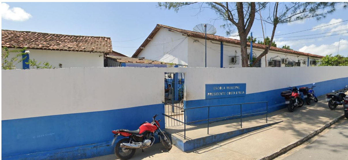
Figura 3: Fachada da Escola Municipal Presidente Costa e Silva, localizada em Tejucupapo, Goiana, PE
