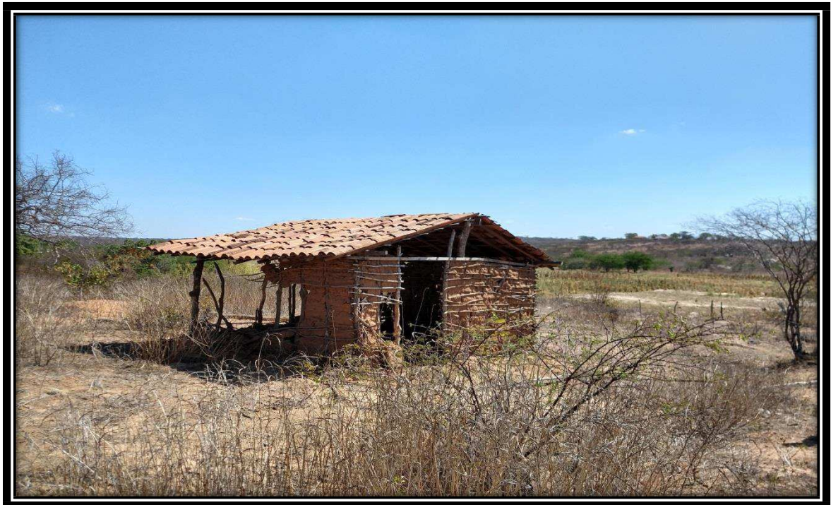
Fotografia 2 - Ruínas de uma casa de taipa na comunidade de Sussuarana - Livramento – PB
