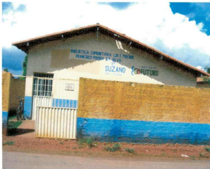
Imagem 16: Biblioteca construída nas dependências da escola no Assentamento Califórnia pela Suzano Papel e Celulose.
