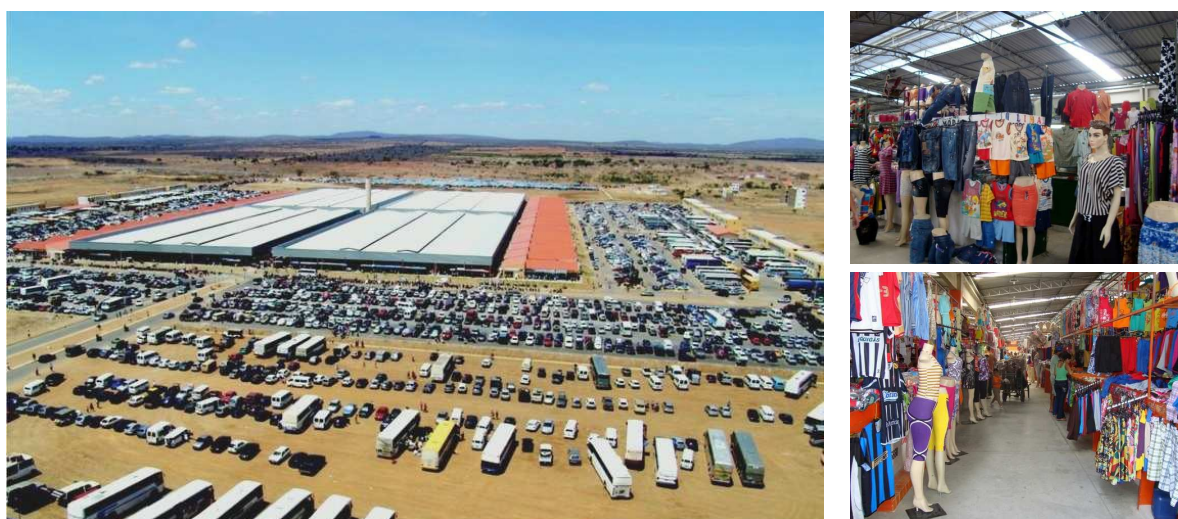
Figura 08. Vista parcial e interna do Moda Center Santa Cruz. Espaço da atual feira da sulanca
