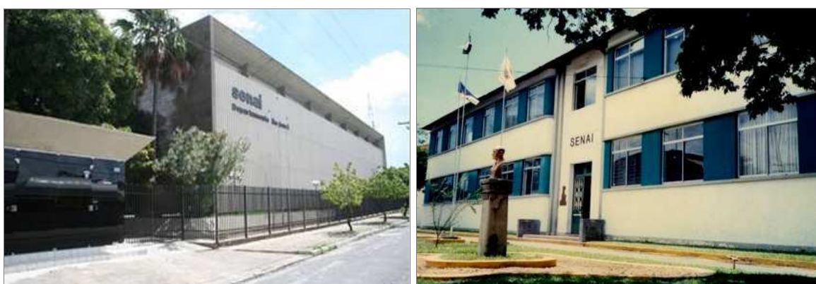
Figura 11. Imagens de prédios do SENAI Pernambuco em Recife
