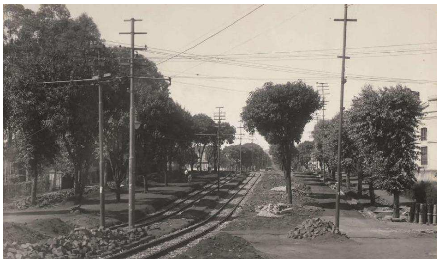
Figura 2.3. Foto de um sistema de distribuição de energia elétrica.
