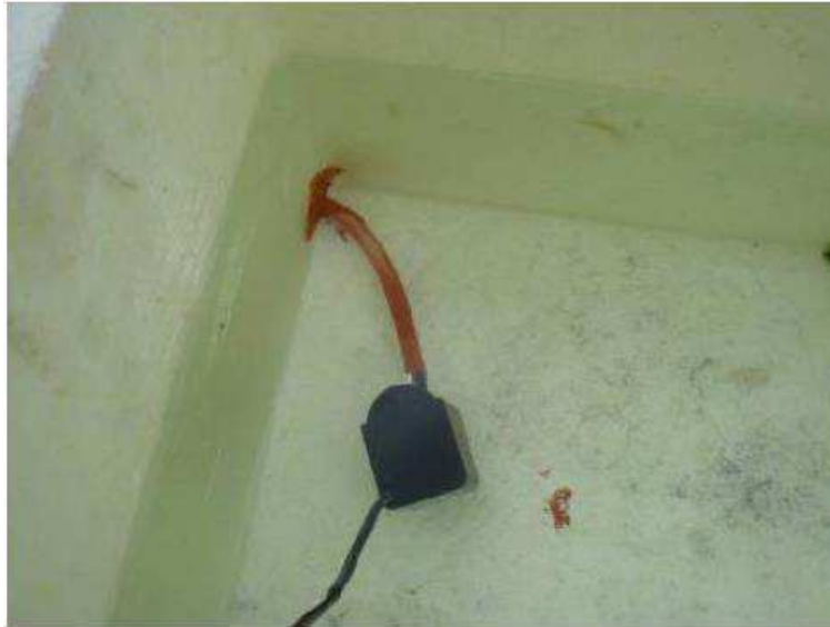
Figura 4.26 - Posicionamento da bomba no interior do reservatório.
