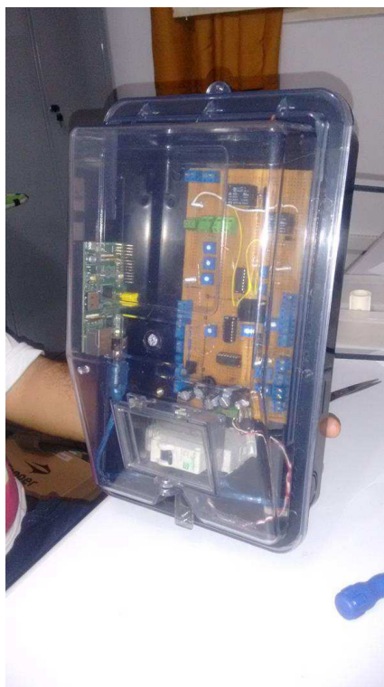
Figura 4.121 - Sistema de aquisição e armazenamento dos dados de temperaturas e vazão
