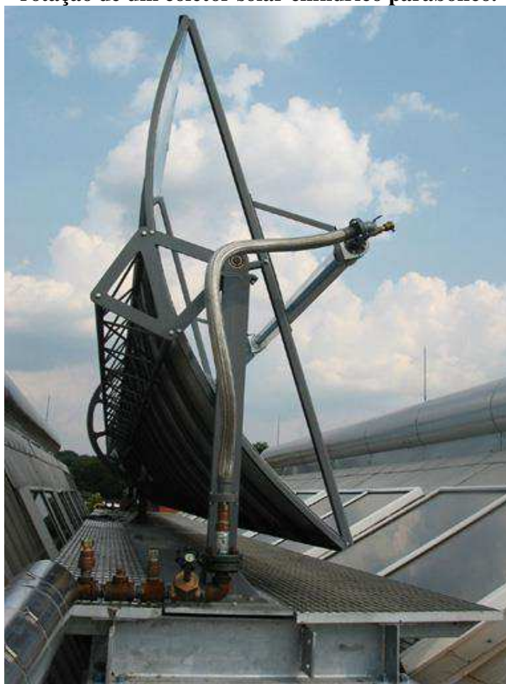
Figura 4.78 - Desbalanceamento na distribuição de massa com relação ao eixo de rotação de um coletor solar cilíndrico parabólico.
