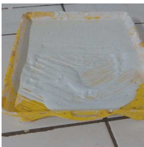
Figura 8 - Bandeja com a tinta pronta para uso na parede
