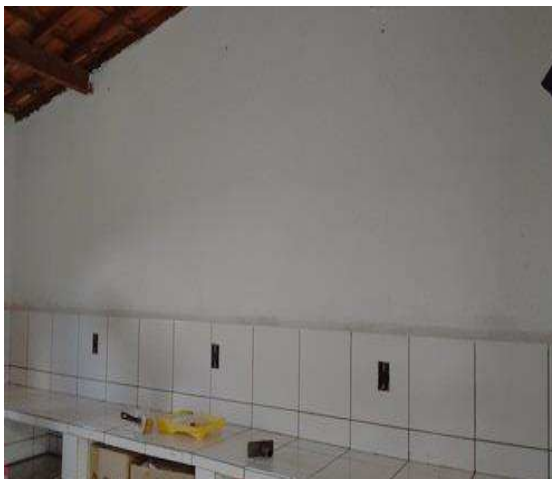
Figura 9 - Aspecto inicial da parede de alvenaria para o estudo de caso
