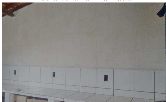
Figura 11 - Pintura com geotinta da parede de alvenaria finalizada
