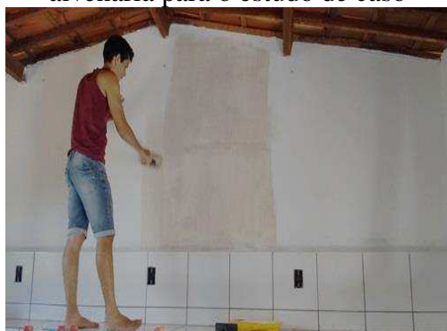
Figura 10 - Aspecto inicial da parede de alvenaria para o estudo de caso
