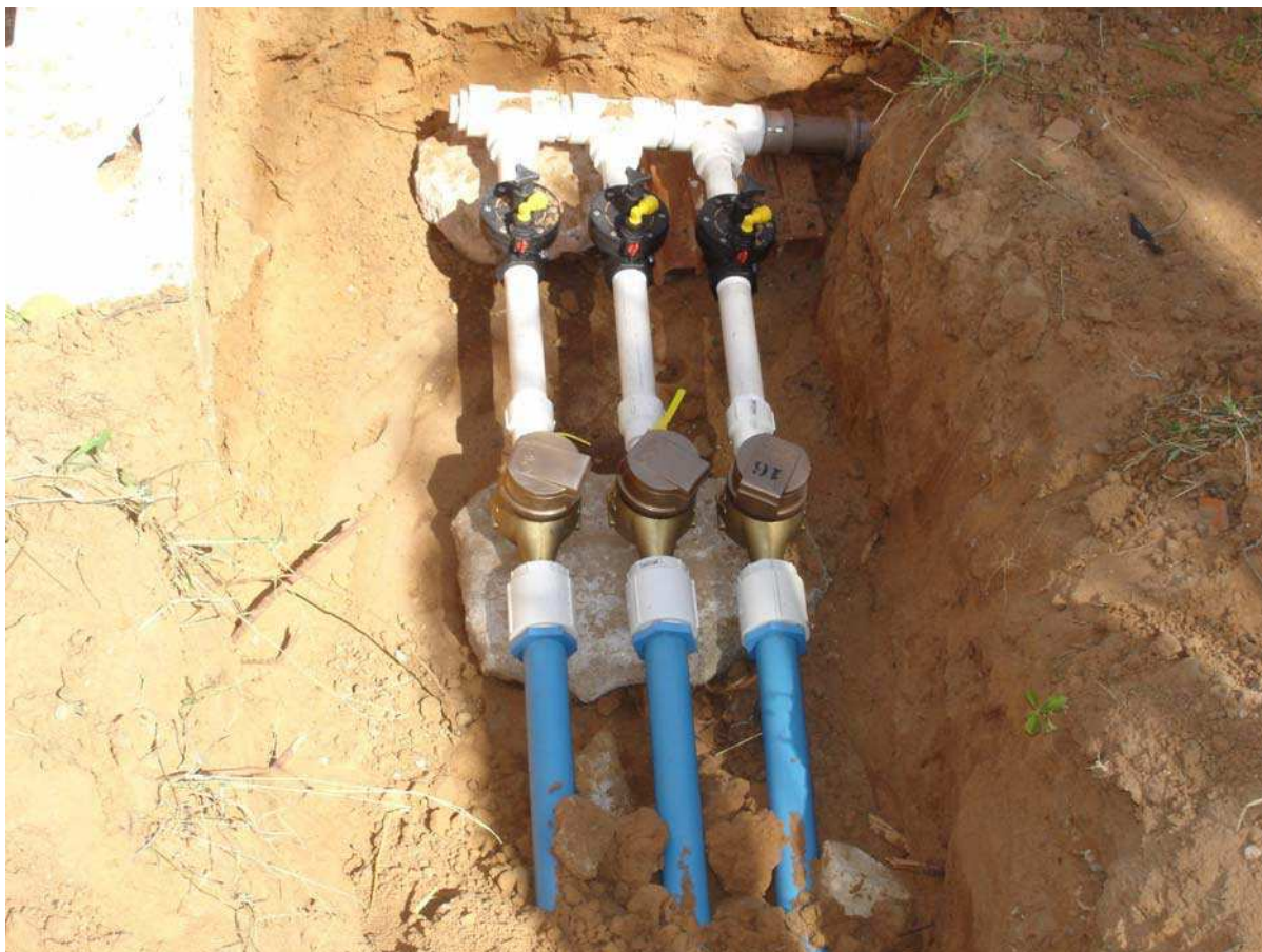
Figura 3.7. Hidrômetros para medir o volume de água aplicado por planta, Petrolina – PE, 2005.
