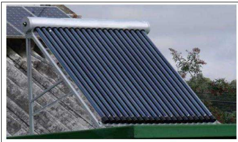
Figura 3.16 - Coletor solar com tubo de vácuo.
