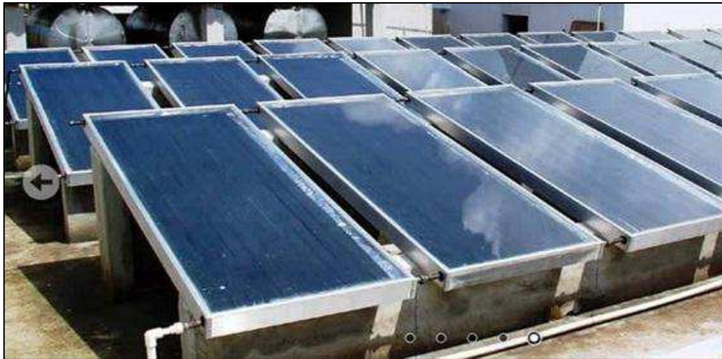
Figura 3.15 – Coletor Solar plano Fechado.
