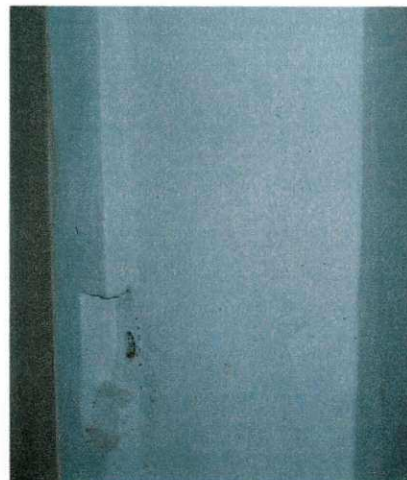
Figura 19b: largura da parede de um das de selas
