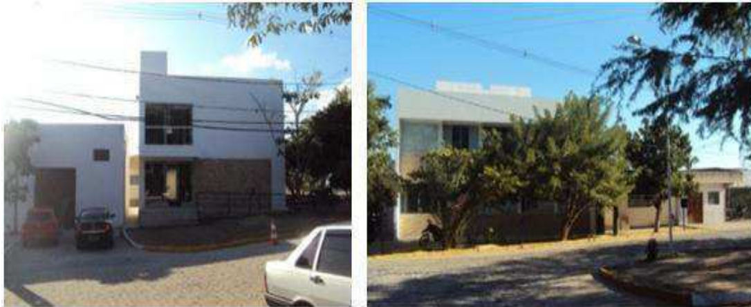
Figura 17 - Edifício Professor Júlio Goldfarb, sede do LEMT/UFPG.
