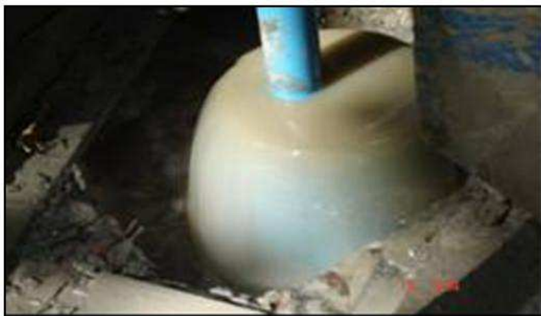
Figura 3.2 - Limpeza do poço com compressor
