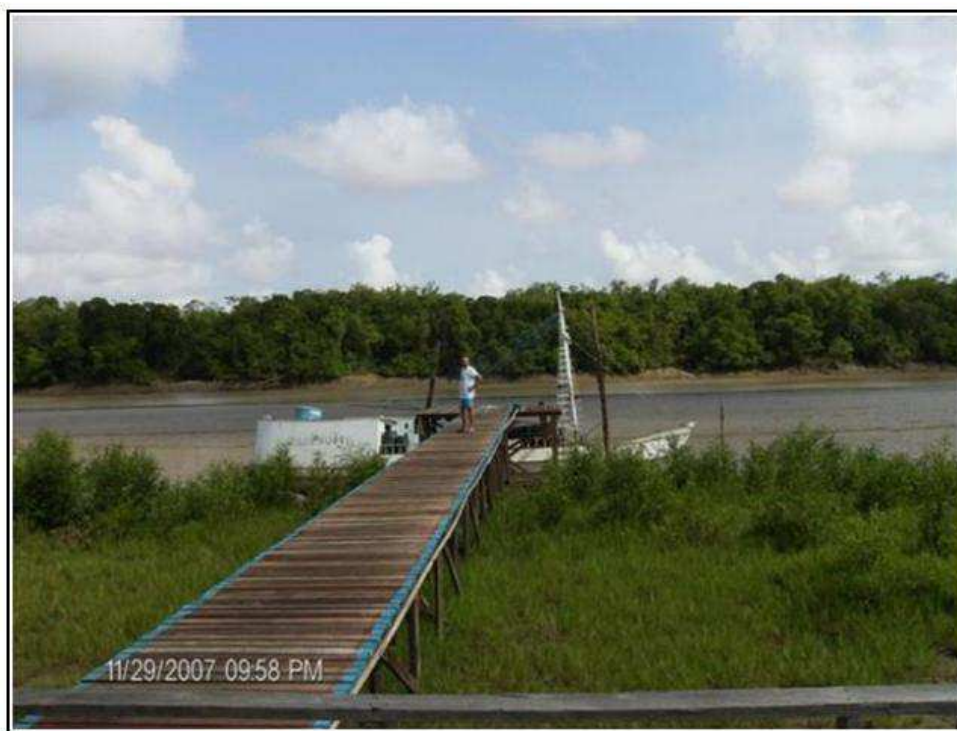
Figura 3.5 - Trapiche da captação da água do rio
