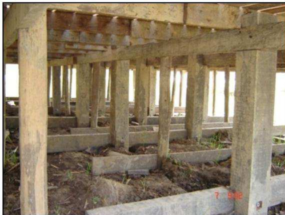
Figura 3.13 - Vista da fundação da plataforma/abrigo
