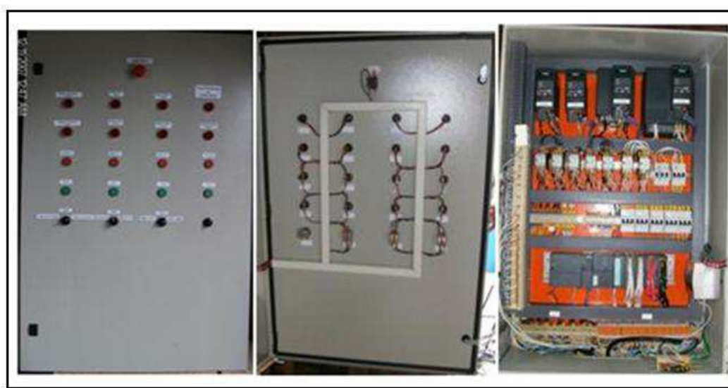
Figura 3.38 - Painel 3 - Painel de automação
