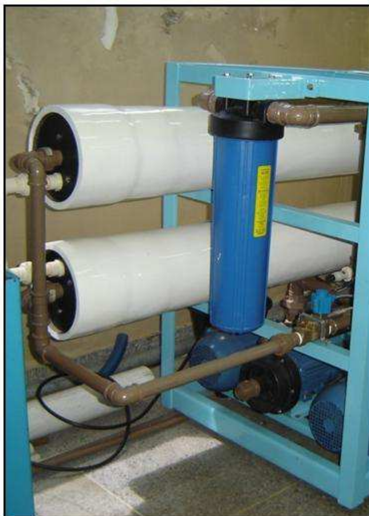
Figura 3.19 - Detalhe do filtro de cartucho e vasos de alta pressão
