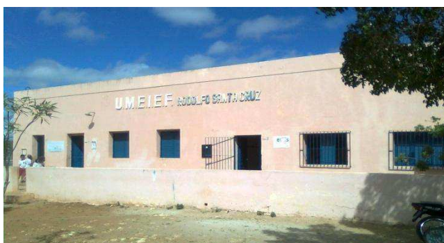
Figura 6: (imagem feita em 03/06/2015, G.F.N.) Foto da fachada Escola Rodolfo Santa Cruz.
