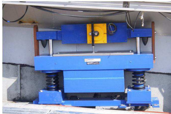
Figura 6 – Absorvedor passivo sintonizado instalado em pontos específicos de uma ponte.
