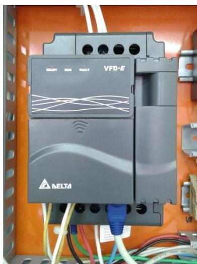
Figura 4.15 – Inversor de frequência (DELTA modelo VFD-E).
