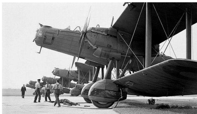
Figura 3 - Handle Page Heyford com seus tirantes e cabos de estaiamento
