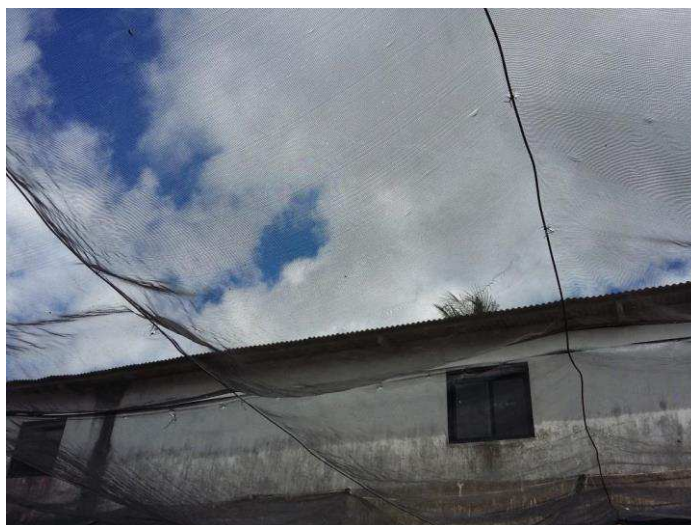
Figura 19 – Tela de proteção e retenção da poeira no ambiente de trabalho
