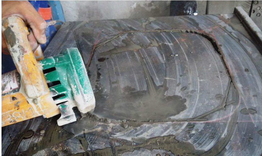
Figura 16 – Desbaste em uma bancada de cozinha no processo de boca de pia
