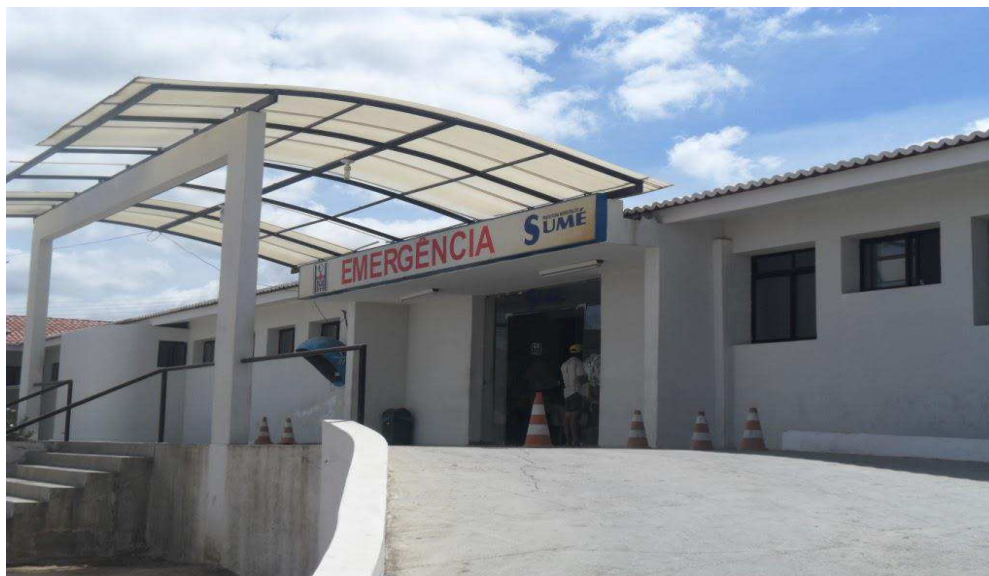
Figura 11 - Entrada principal do Hospital e Maternidade
