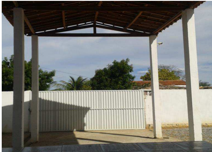
Figura 6: Entrada de caminhões
