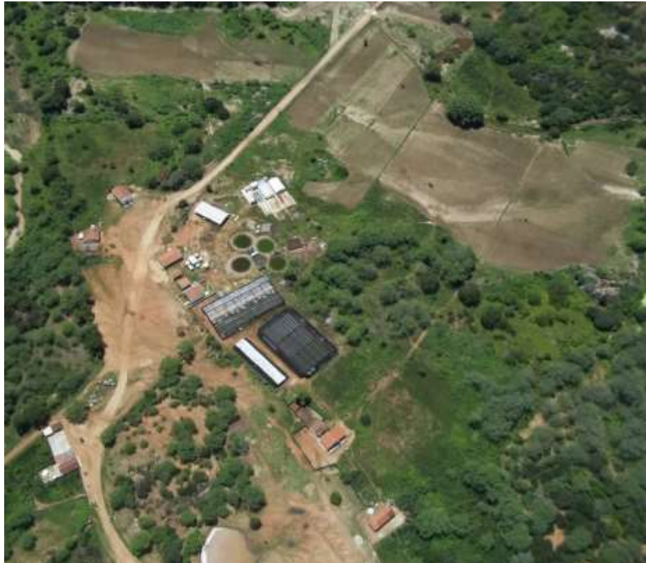
Foto 1 – Vista aérea da HIDROÇU
