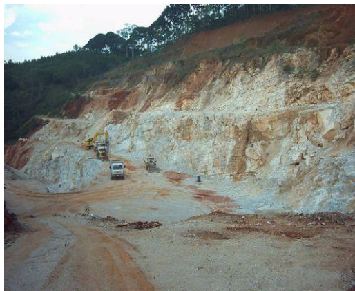
Extração mineral para fabricação de cimento
