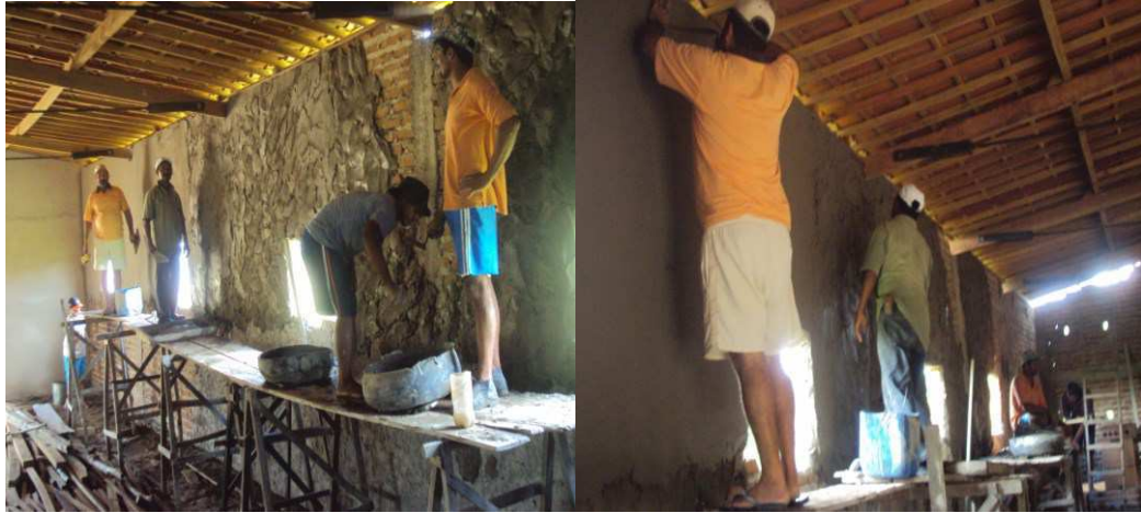
Mutirão nas obras de construção da sede da Associação. Foto nº 19. Fonte: arquivos da AMUABS.
