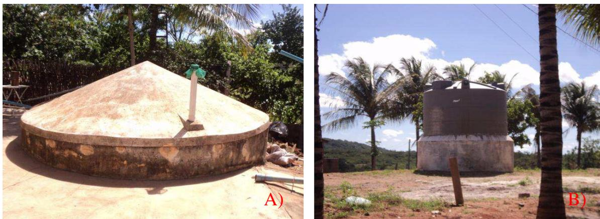
Figura 85- A) Cisterna de placas e B) Cisterna de plástico utilizadas para armazenamento de água no entorno da bacia hidráulica. Fonte: A autora (2016).
