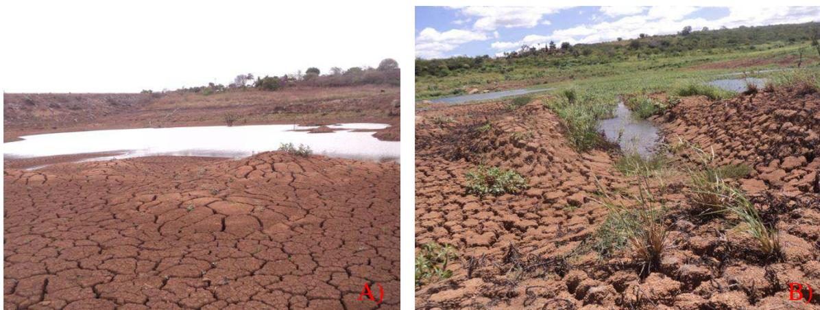
Figura 104- A) Bancos de terra nas proximidades da parede do açude e B) Assoreamento na parte central do reservatório. Fonte: A autora (2016).
