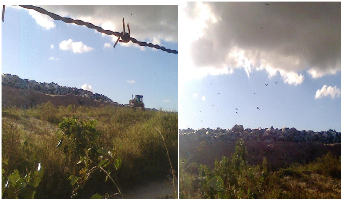
Figura 12 – Cobertura dos resíduos sólidos no aterro sanitário de Puxinanã-PB.
