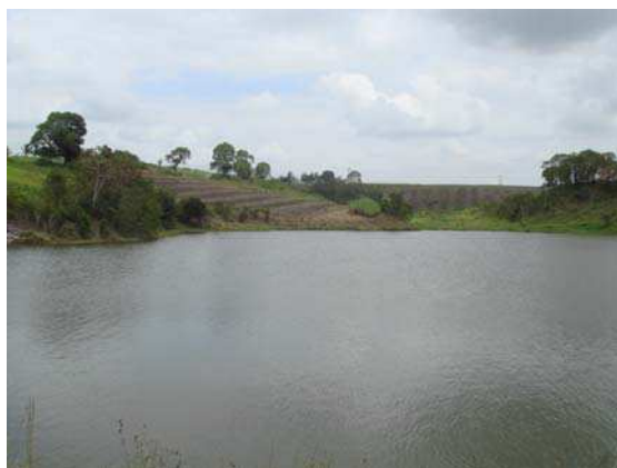
Foto 6 - Margens do açude na nascente utilizada pela agricultura em Áreas de Preservação Permanente 2007.
