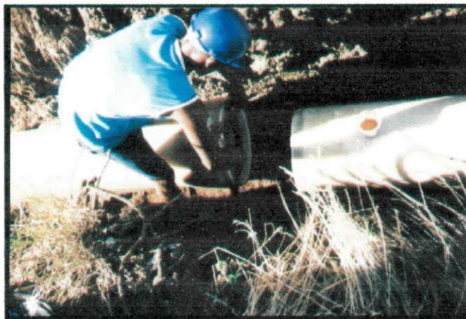
Integração de bacias (Adutora do Congo, 08/2003)
