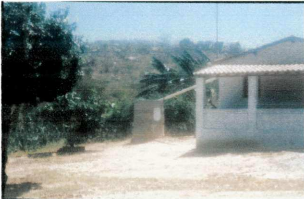
Construção de cisternas rurais ( Sumé, 08/2002)
