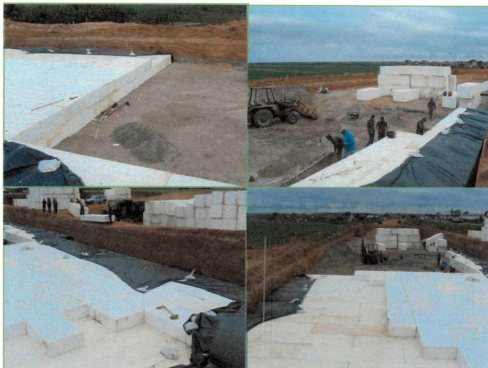
Figura 3.6 – Solução em EPS executada pelo 3º BEC.
