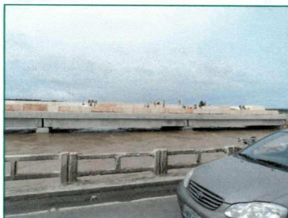
Figura 3.16 – “Transversinas” do Canal Goiana parcialmente cobertas por água.
