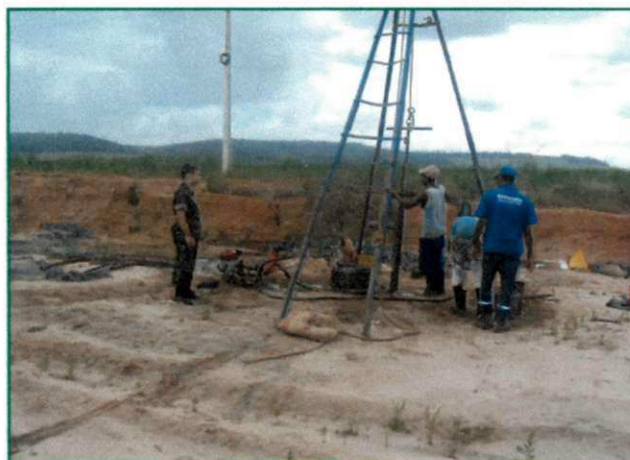
Figura 3.8 – Ensaio SPT executado no Aterro 3.
