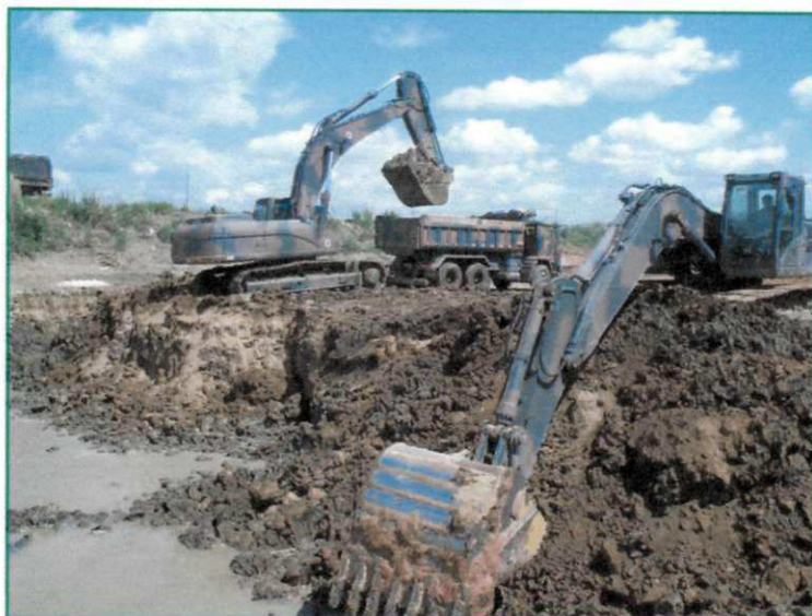
Figura 2.7 – Remoção de argila mole.
