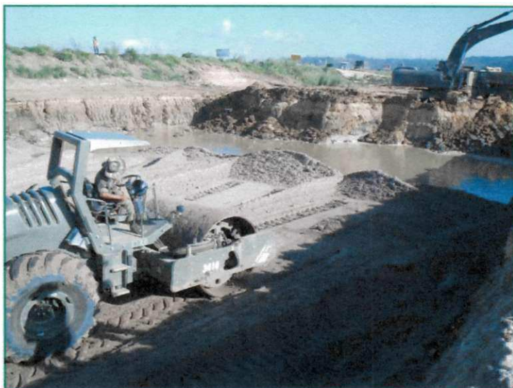
Figura 2.8 – Substituição da argila mole por areia.
