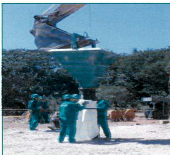
Figura 3.3 – Colunas de areia confinada com geossintético.
