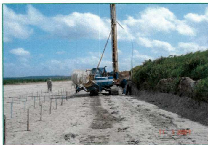
Figura 2.10 – Equipamento utilizado para cravação de geodrenos.
