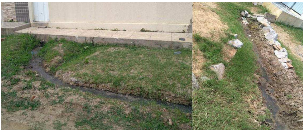
Foto 10. Esgotos a céu aberto no entorno de residências.
