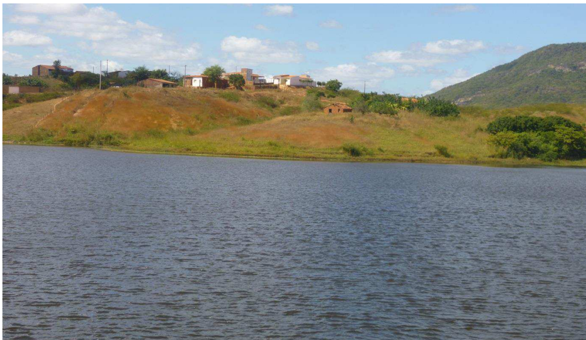
Foto 7: Crescimento urbano já bem próximo ao reservatório.
