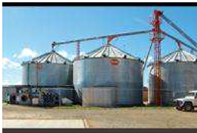
Figura 4: Secador de Forno ou “ Bin-dryer ”.
