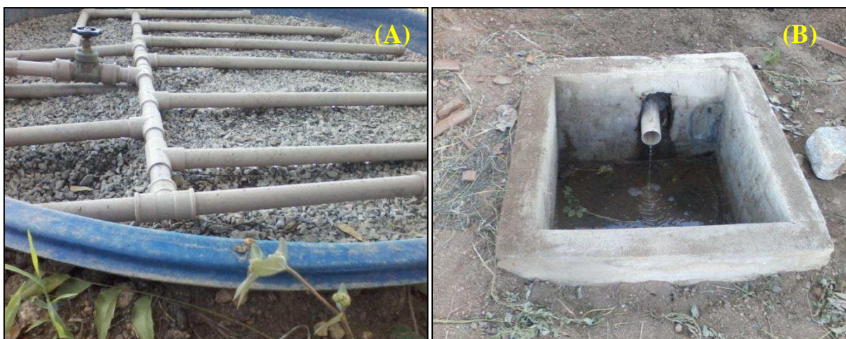
Figura 4. Filtro com fluxo intermitente em funcionamento (A), fonte de esgoto utilizado para o tratamento e irrigação na cultura do quiabeiro(B). Pombal/PB, 2014.
