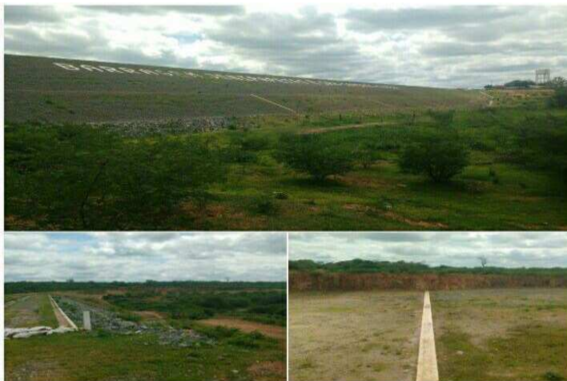
Figura 05 – Estrutura da Barragem Jenipapeiro.
