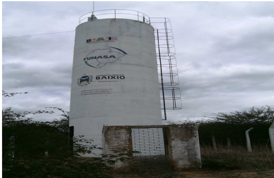
Foto 9 – Caixa que disponibiliza água canalizada.
