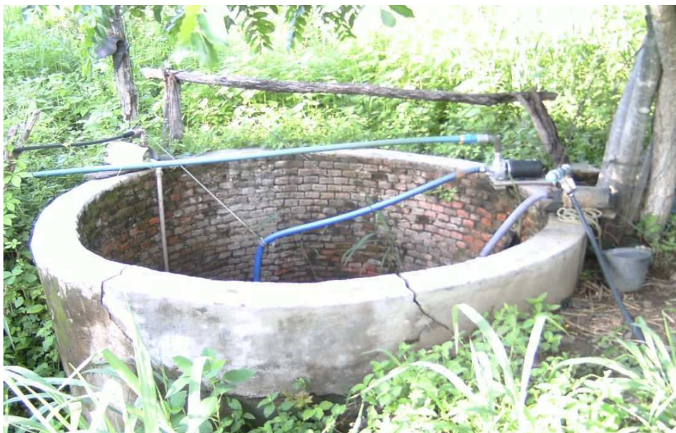
Foto 14 – Poço Profundo (cacimbão) em propriedade privada.
