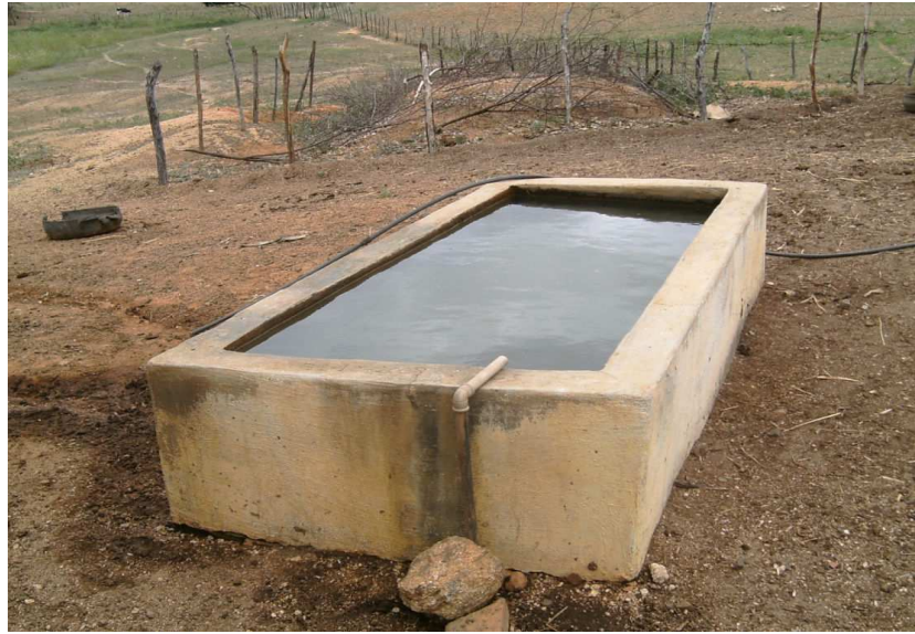
Foto 13 – Tanque de alvenaria.
