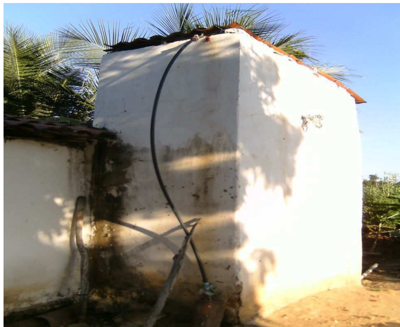
Foto 12 – Caixas d'água de alvenaria.
