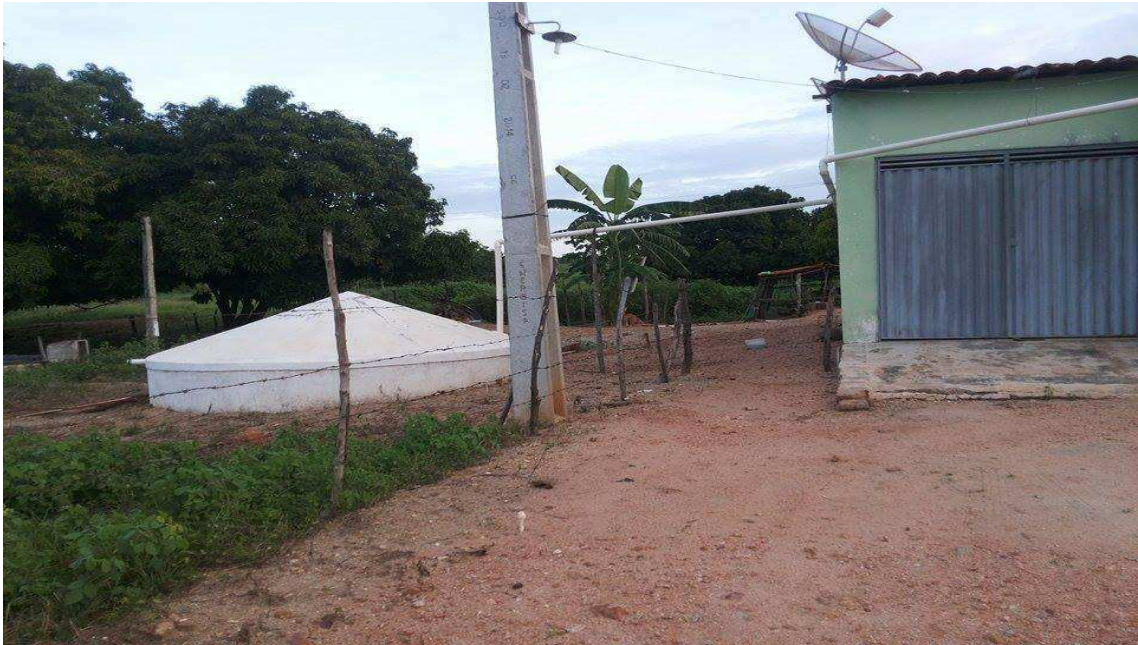
Foto 10: Cisterna de placas na comunidade, 16 mil litros, MOTA (2017).
