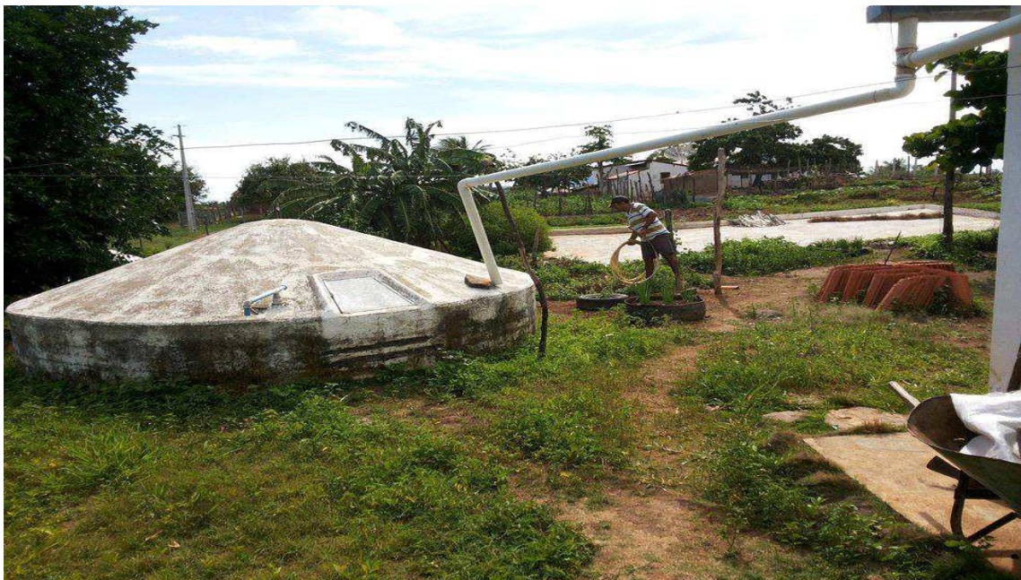
Foto 13: Cisterna de placa, 16 mil litros e vista do calçadão da outra cisterna, MOTA (2016).
