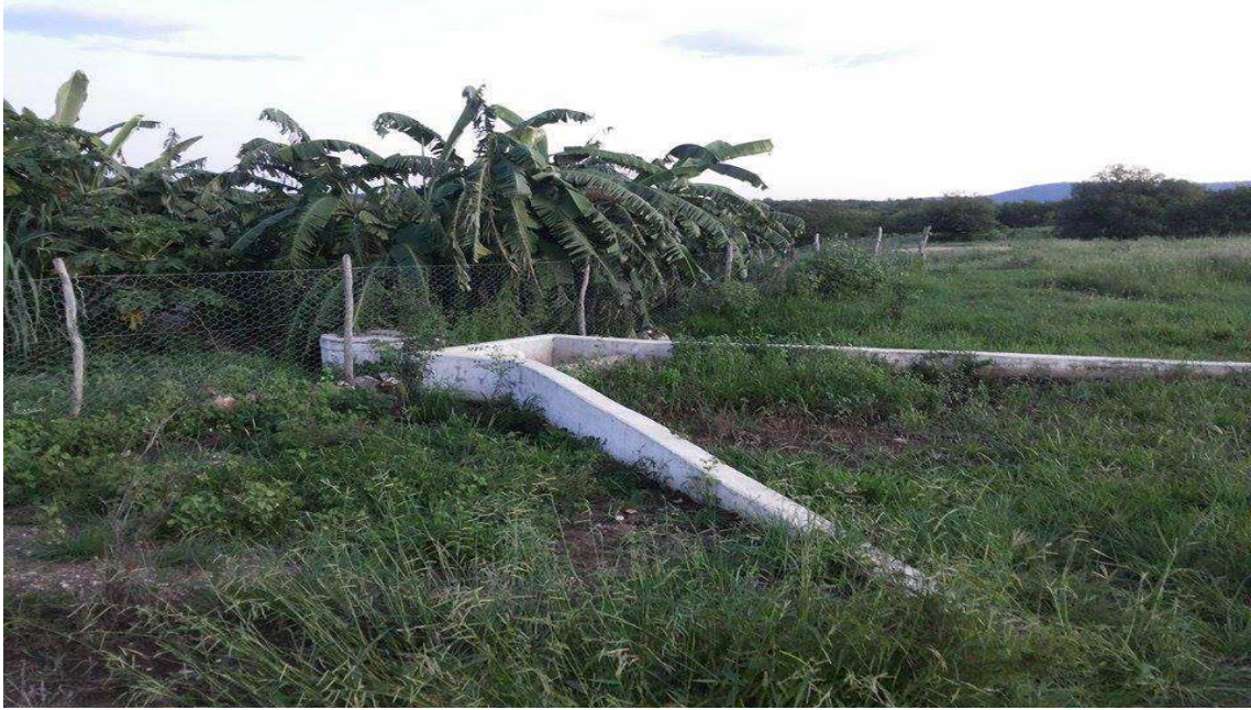
Foto 12: Cisterna enxurrada, 52 mil litros, MOTA, (2017).
