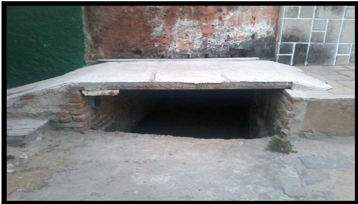
FOTO 14 – Outra galeria pluvial que vai pro Açude Grande – Rua São Sebastião
