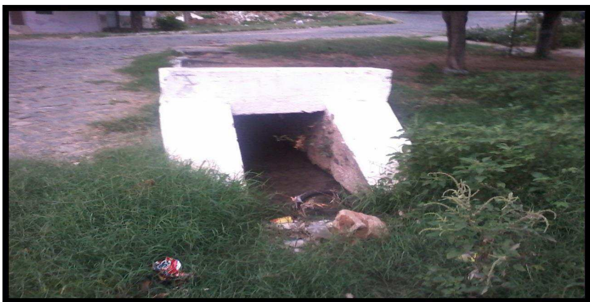
FOTO 17 - Rede de galerias pluviais destinada ao Açude Grande – Travessa Crispim Coelho
