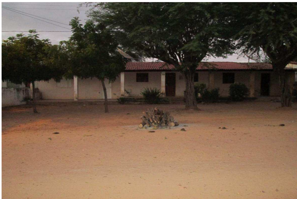
Imagem 09 - Casa do colono com estrutura original alterada
