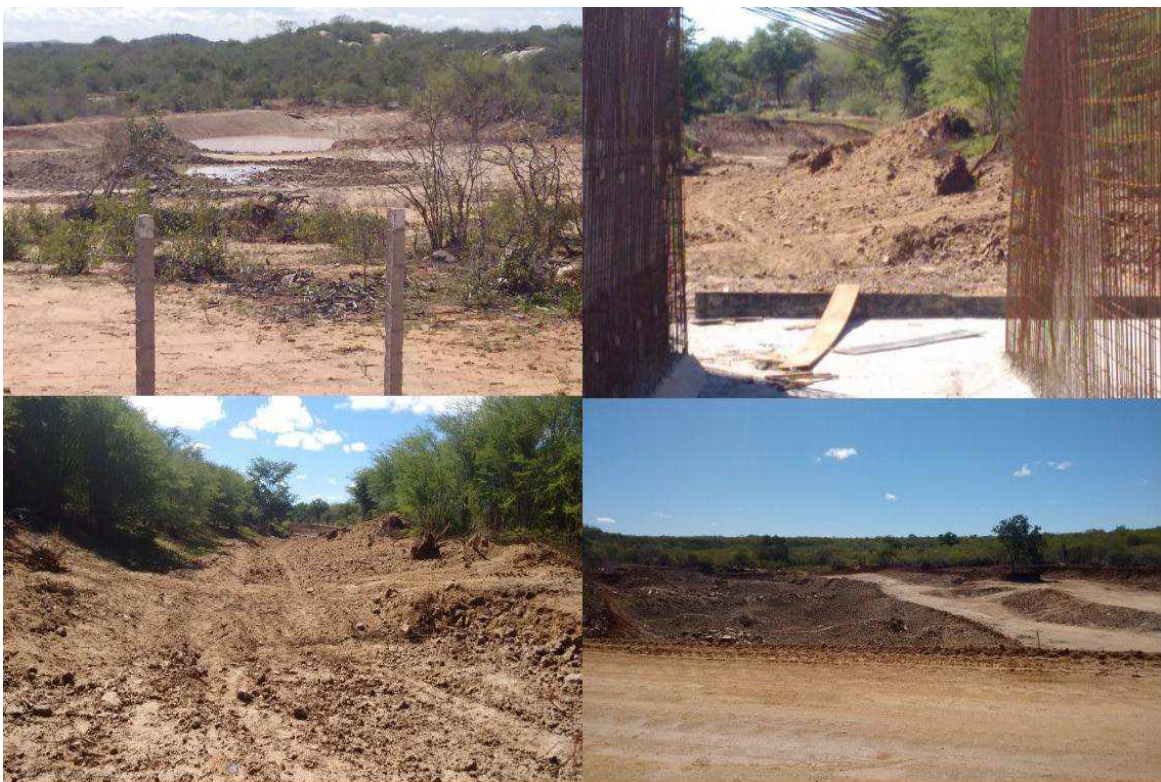
Figura 19: Estruturas para mudança da drenagem das águas no trajeto da rodovia PB-200. Foto: Santos, 2015.
