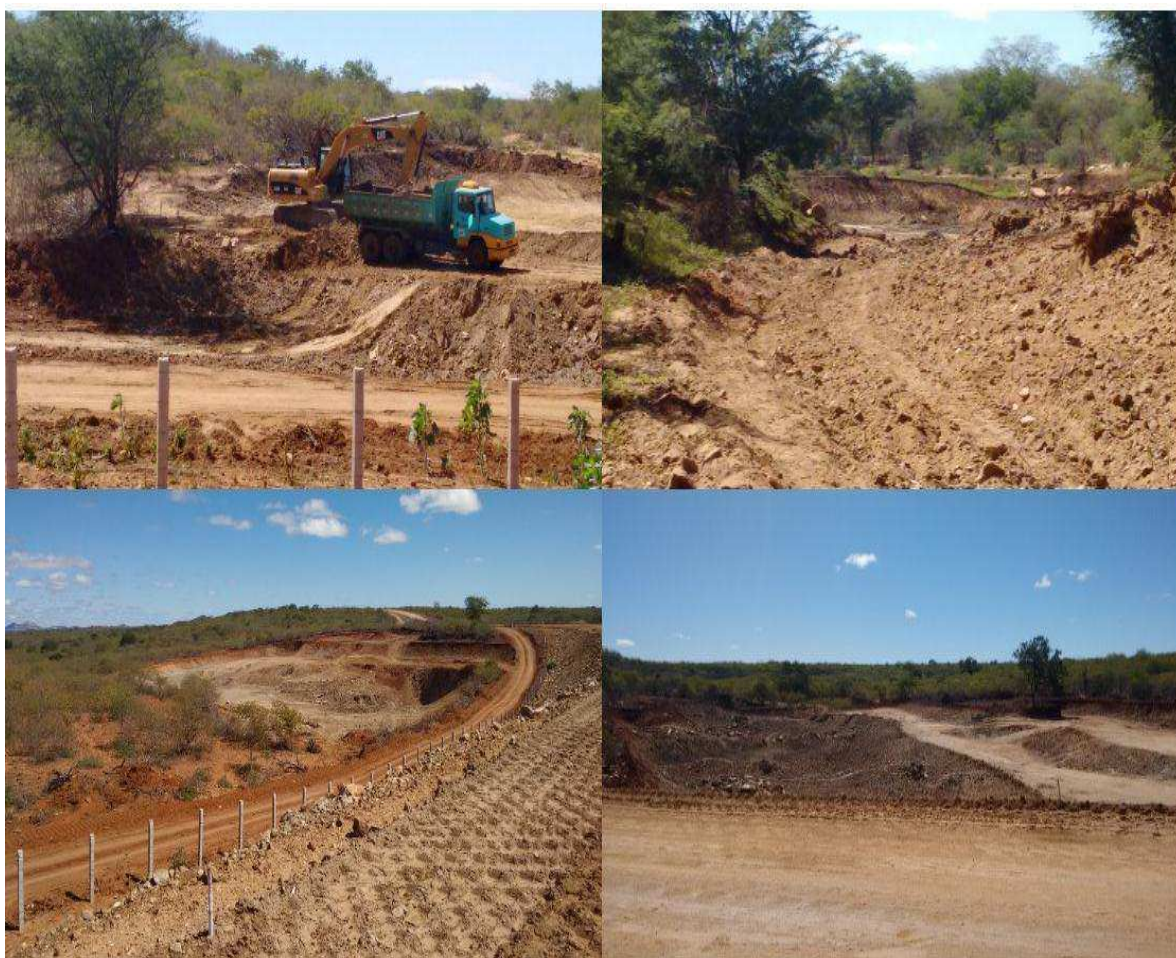
Figura 16: Remoção do solo nas margens da rodovia PB-200. Fonte: Santos, 2015.
