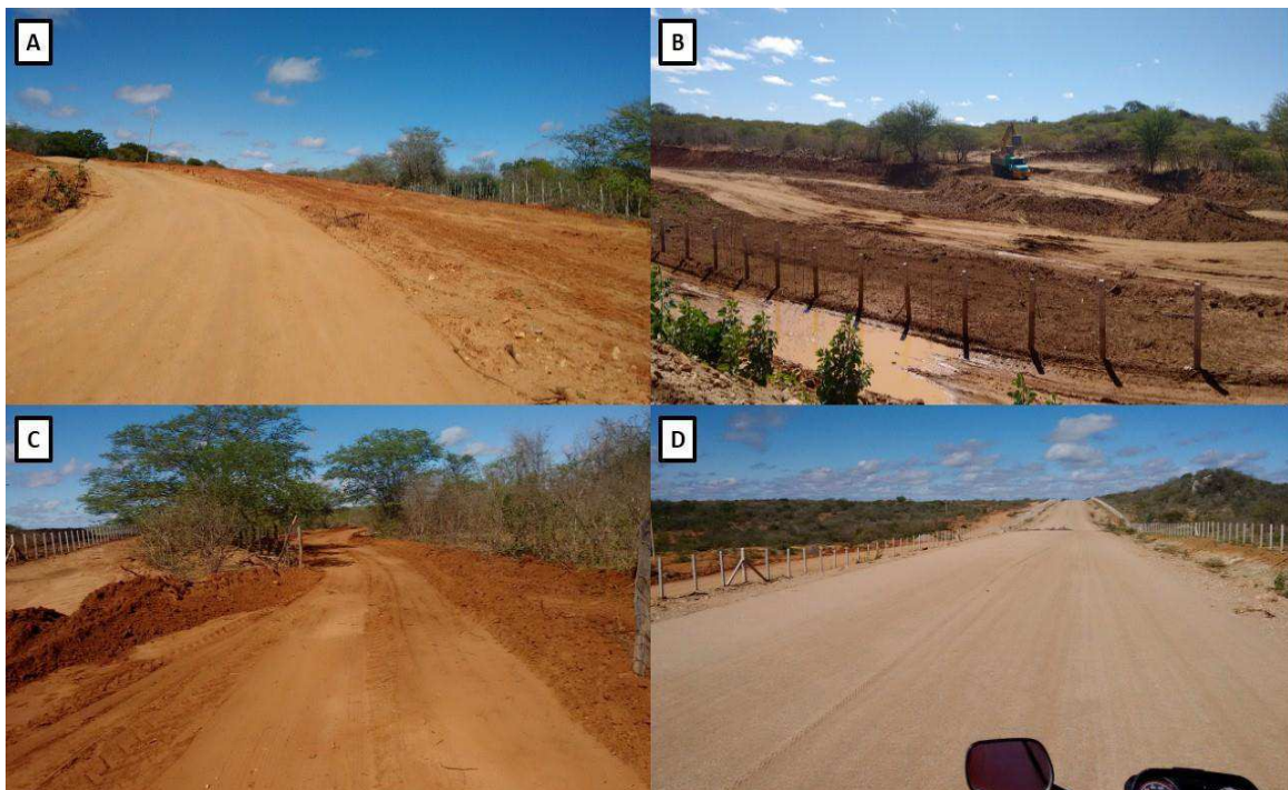
Figura 22: (A) retirada de vegetação as margens da rodovia (lado esquerdo da imagem); (B) terreno desmatado para remoção de solo e minérios; (C) desvios provisórios de trânsito; (D) Mata nativa da Caatinga desflorestada para formação de nova rodovia. Fonte: Santos, 2015.
