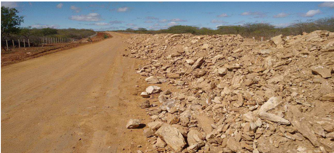
Figura 13: Sedimentos rochosos utilizados no aterramento da rodovia PB-200. Fonte: Santos, 2015.
