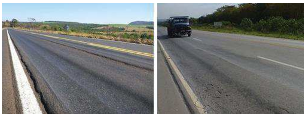
Figura 3 – Deformação permanente: a) por densificação e b) por movimentos laterais.
