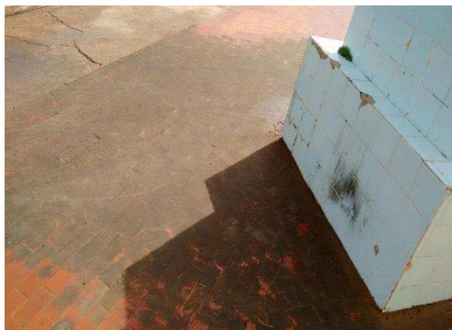
Figura 22- Parte do piso danificado por parte das velas. Fonte: acervo do autor. (04/04/2018)
