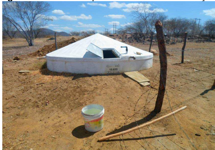
Figura 8 - Cisterna de placa na comunidade Maniçoba
