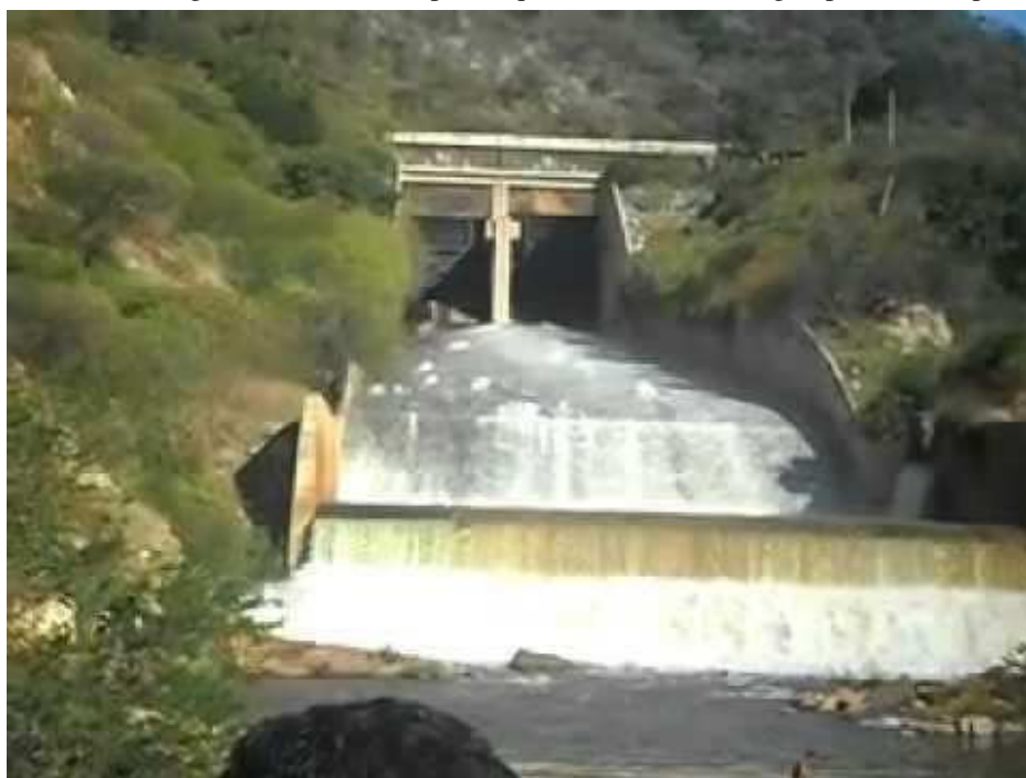
FIGURA 9: sangria através das comportas que substituíram a sangria por cima da parede.
