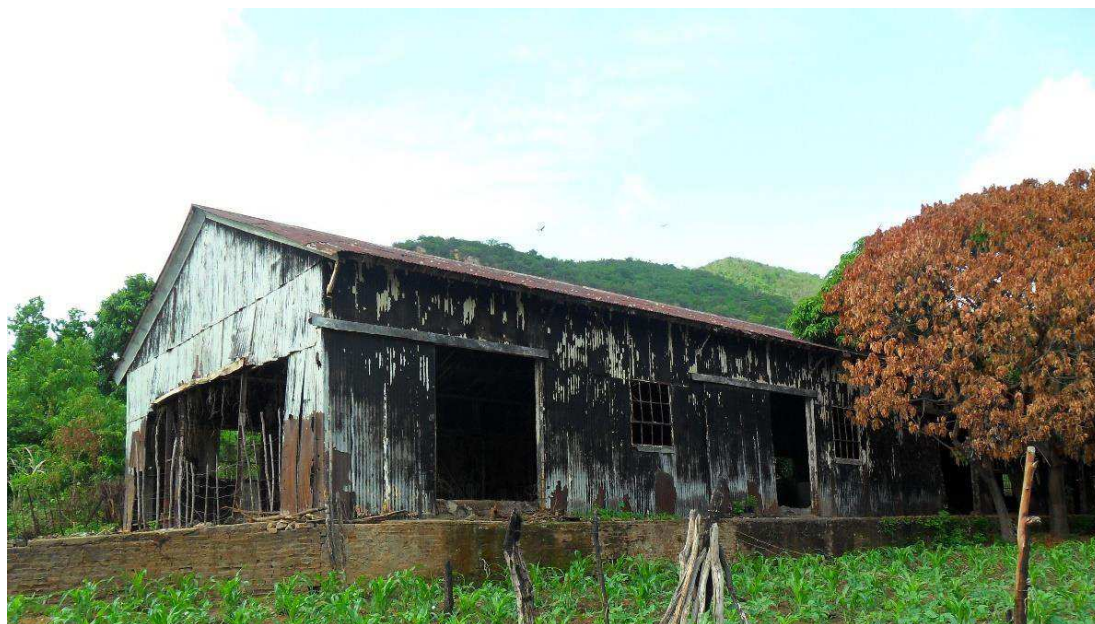
FIGURA 2: galpão para guarda do maquinário usado na construção do açude.
