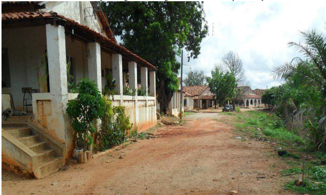
FIGURA 1: casarões que abrigavam os engenheiros da construção do Açude Piranhas
