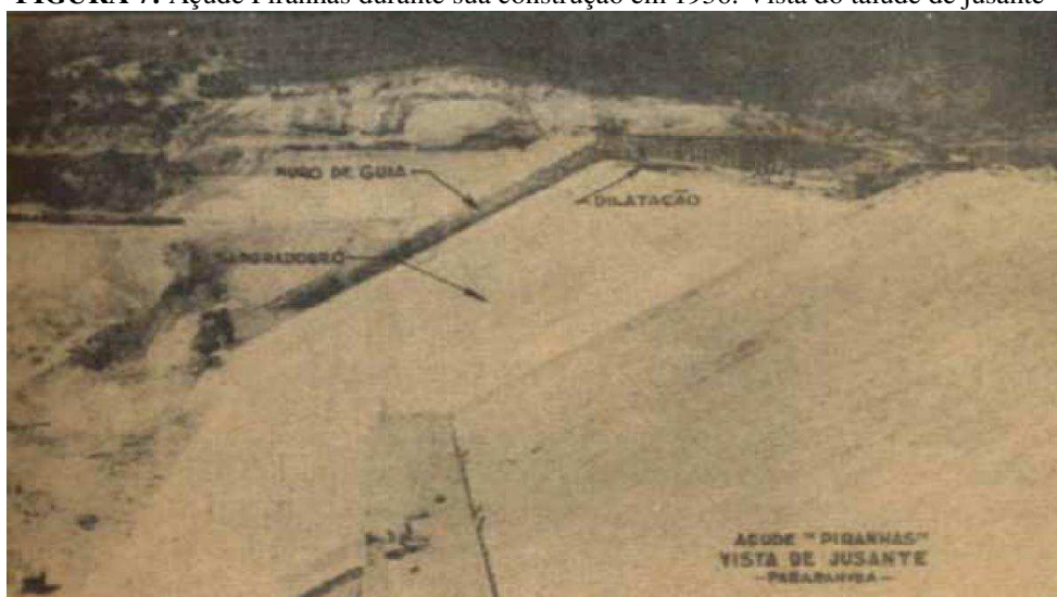
FIGURA 7: Açude Piranhas durante sua construção em 1936. Vista do talude de jusante
