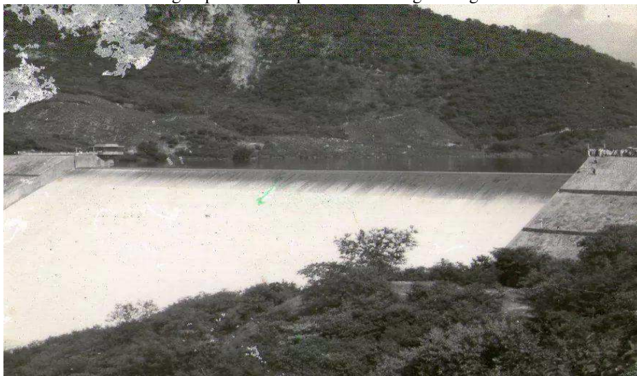
FIGURA 8: sangria por cima da parede da Barragem Engenheiro Ávidos.
