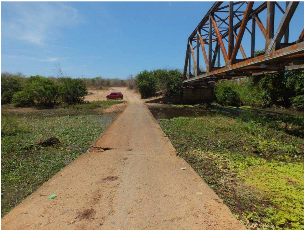
Figura 5: Barragem Riacho do Rosário
