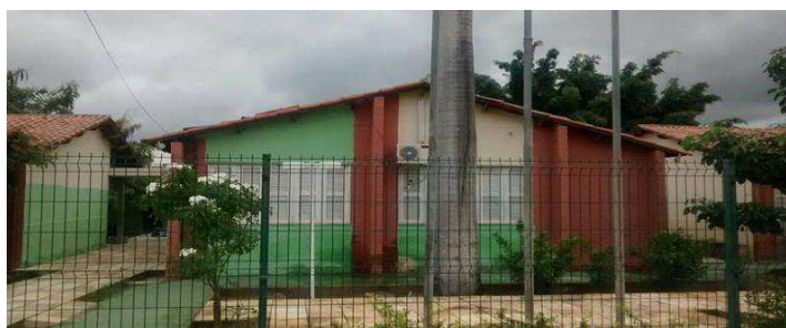
Figura 3: Fachada da Escola Estadual de Ensino Fundamental e Médio Dona Carlota Távora.
