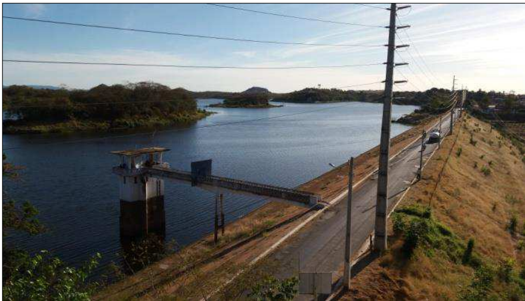
Fotografia 3- Parede e torre de monitoramento do Açude de São Gonçalo
