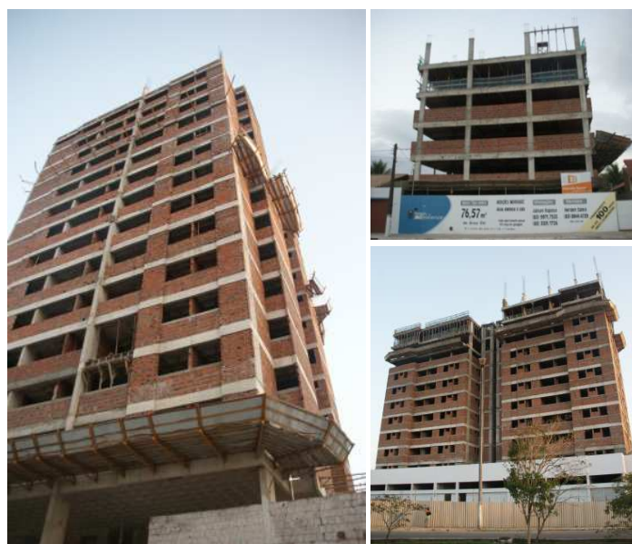
Figura 18- Edifícios em construção no Catolé
