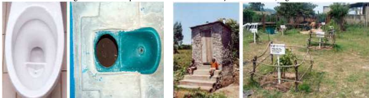
Figura 4 – Vaso separador de excretas e utilização em Kissorso, Uganda.
